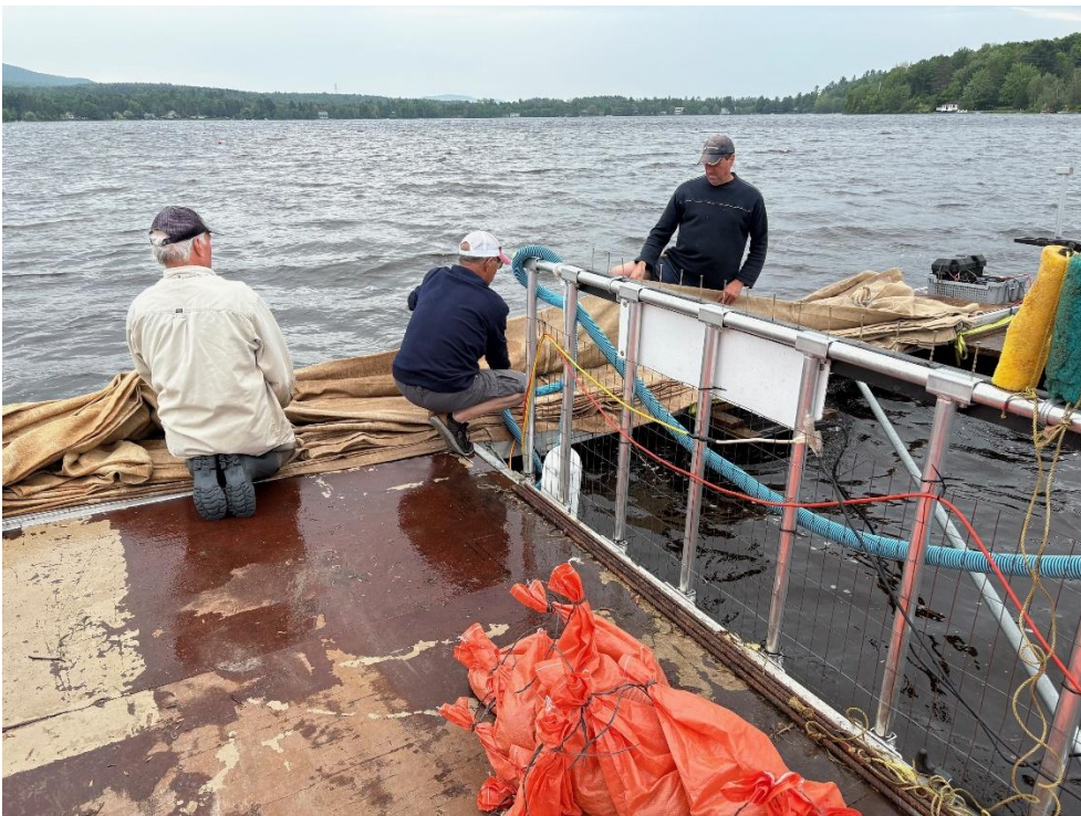
Installation de toiles de jute sur le ponton transformé
